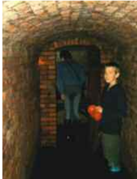
Besichtigung im Stollen. Quelle: Stadt Obernkirchen.
