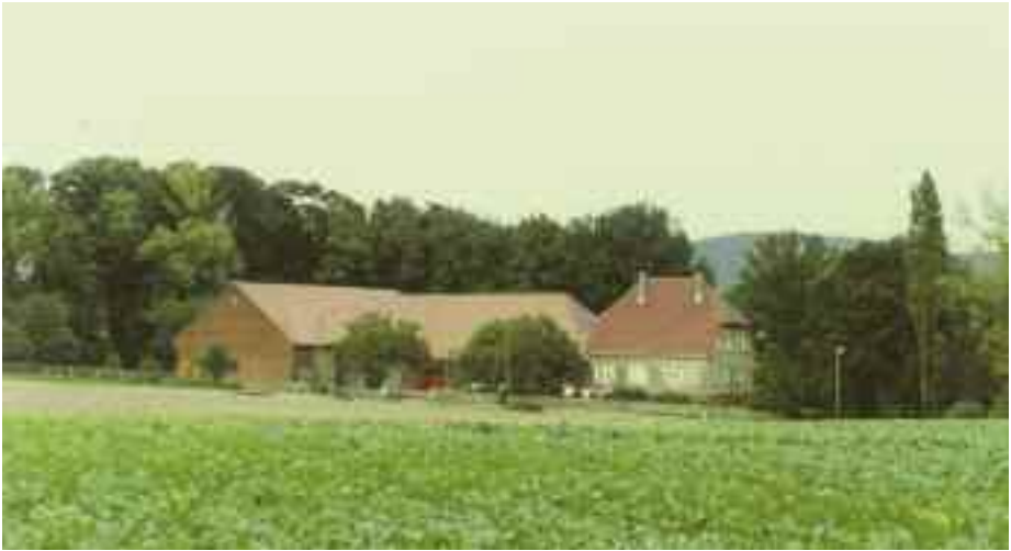
Hof Peithmann in Wulferdingsen Nr. 3 mit dem 1914 errichteten Wohnhaus.
