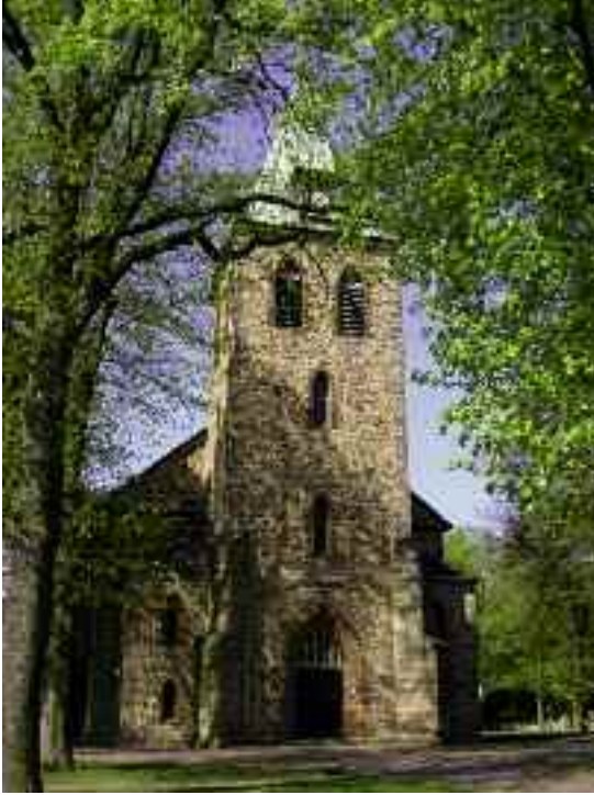
Der 1930/31 errichtete neue Turm der 1820 erbauten Kirche zu Mennighüffen. Quelle: Ev.-luth. Kirchengemeinde Mennighüffen.
